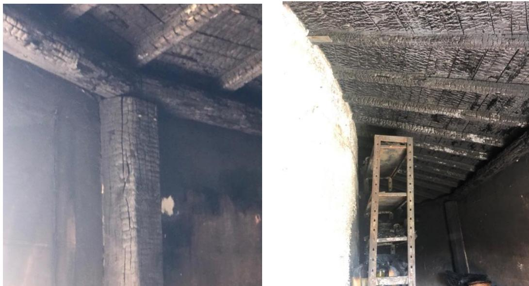
Il Cuore della Sagrestia, quello dietro l’abside è stato danneggiato parzialmente nella struttura secondaria in legno, in buone condizioni la struttura in ferro. La Struttura, inclusa la copertura, sarà oggetto di messa in sicurezza e risanamento strutturale che si alleggerà alla presente relazione sotto il punto 3
